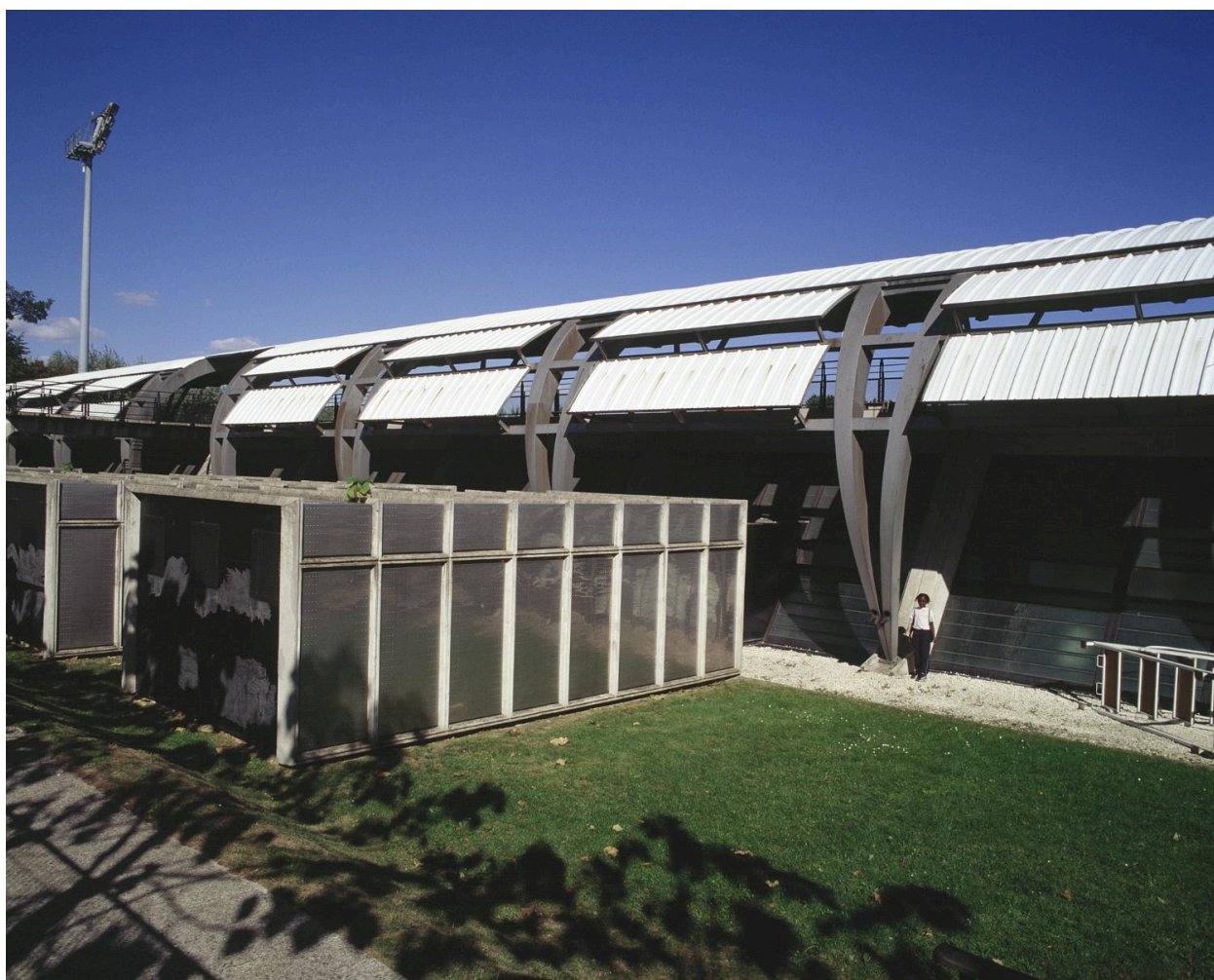
Détail de la structure de la nouvelle tribune.
