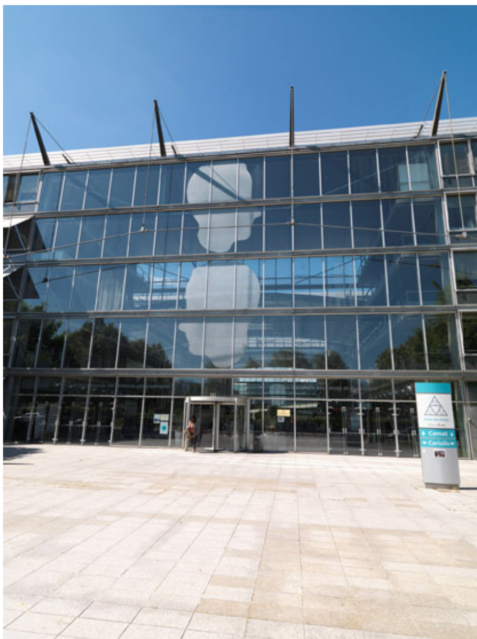
Vue de la façade principale au sud.
