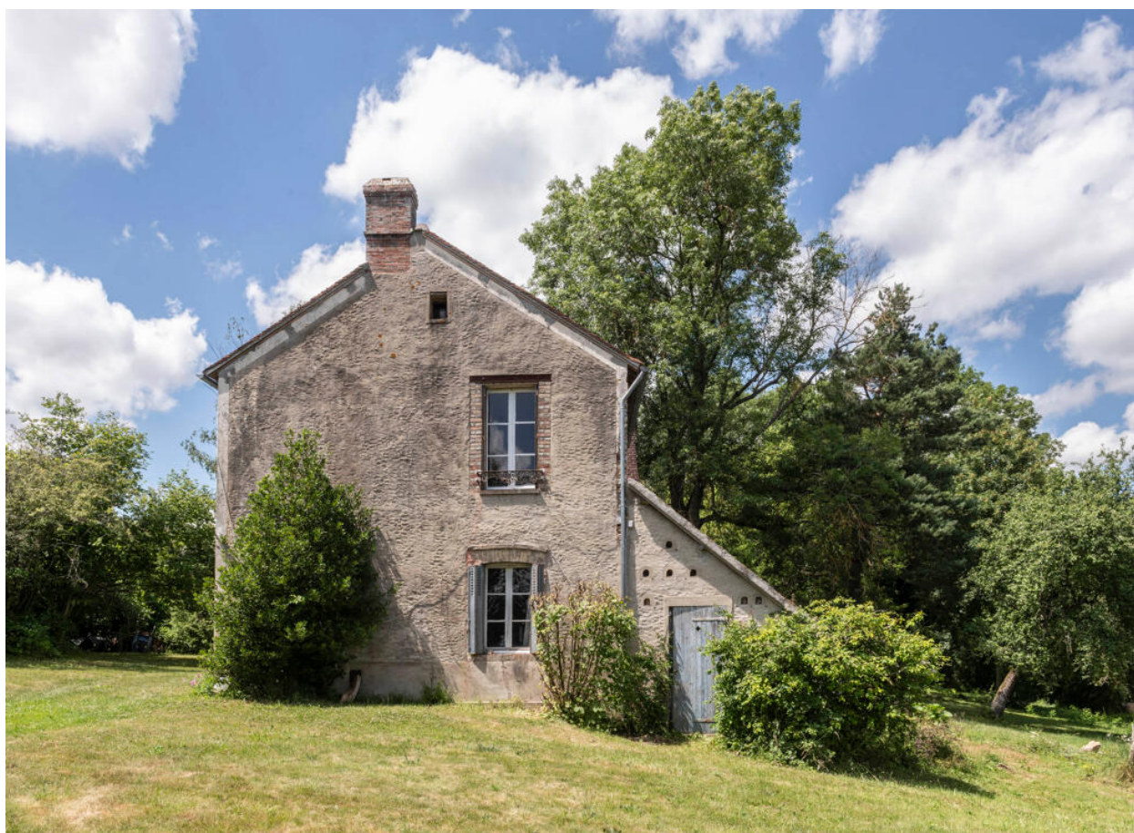
Corps de logis, façade est
