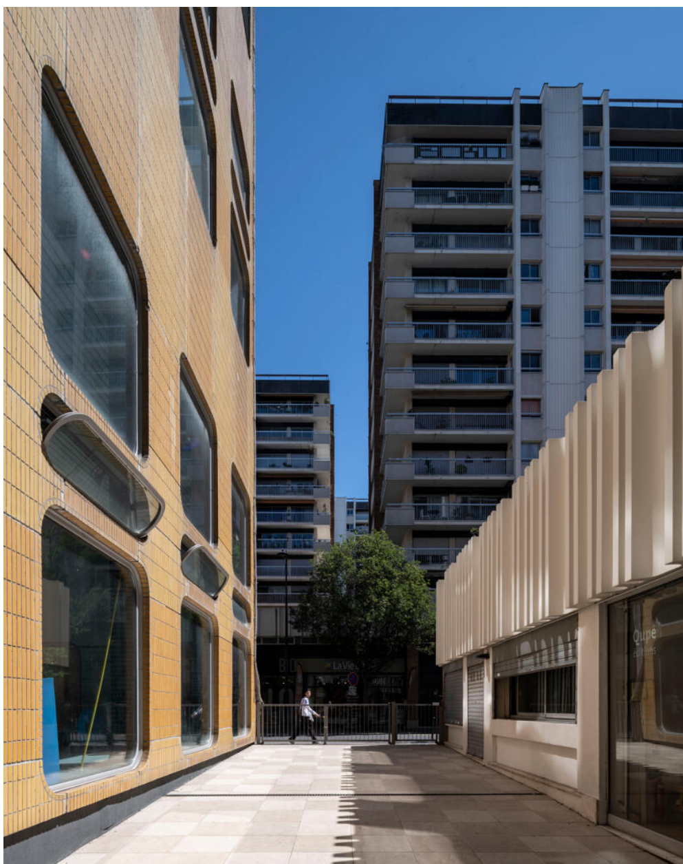
Piscine et gymnase de la Cour des Lions. 9, rue Alphonse Baudin, 75011 Paris
