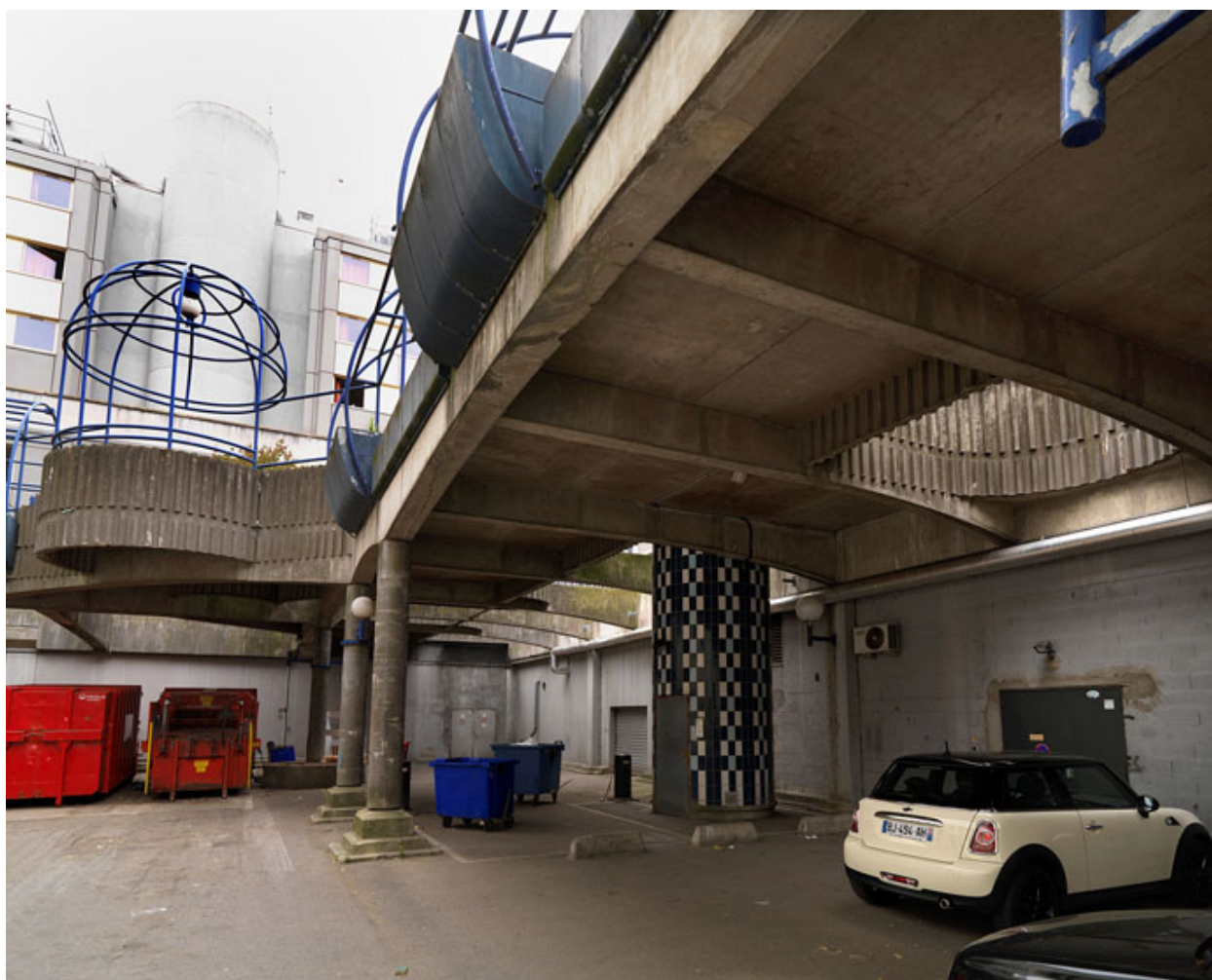
Passerelle en béton, rue de la Pergola, 1975-1980.
