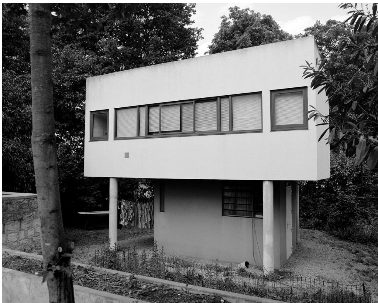
Vue de la maison de gardien à l'entrée de la propriété.
