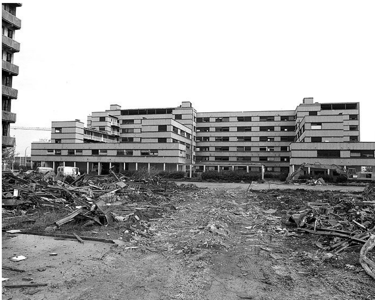
Bâtiment A, façade sud. Campagne photographique, lors de la destruction du bâtiment en 1976.
