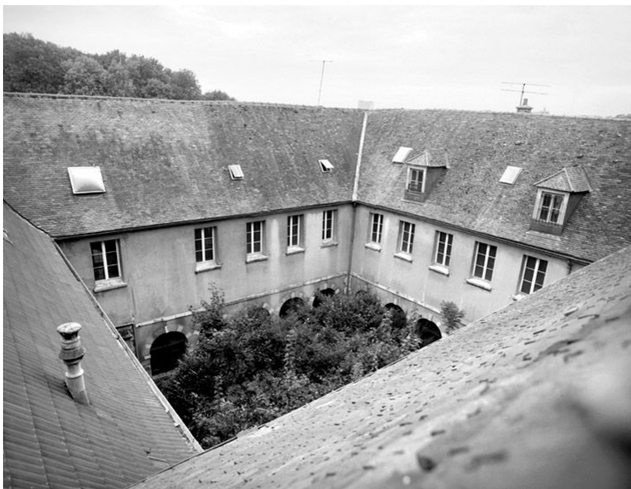
Vue du cloître, prise depuis la charpente de la chapelle.
