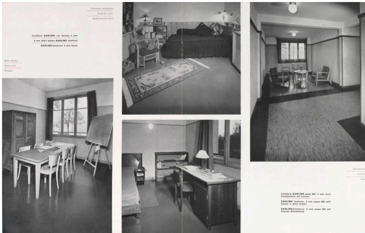
Vues de la salle d'étude, de deux chambres d'étudiants, ainsi que d'un des dégagements aménagés en coins-salons dans les étages. 1956. Photographie. Archives nationales, 20090013/141.
