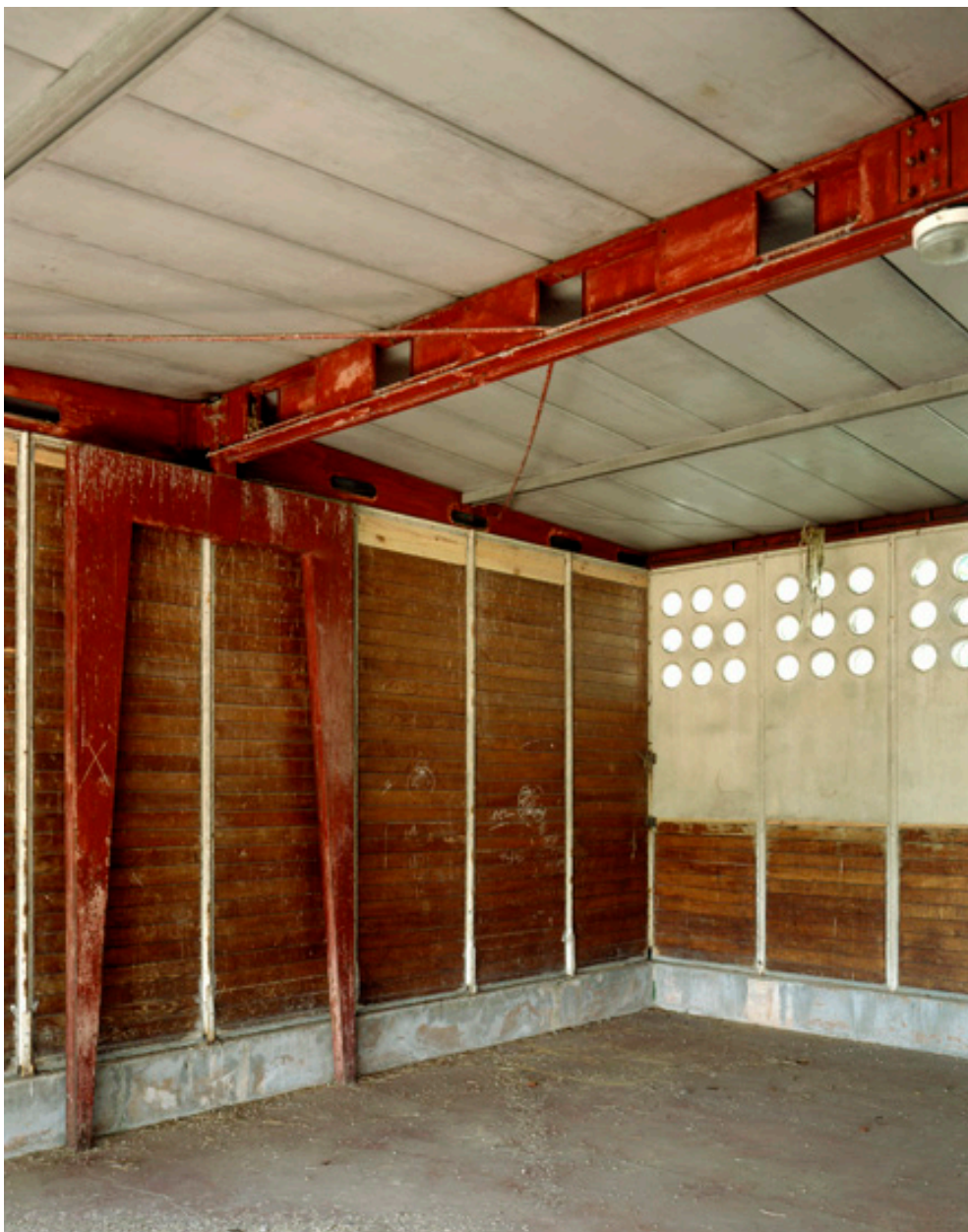
Vue intérieure sous préau. Détail de la structure "système à portique axial". Réalisé par Jean Prouvé.
