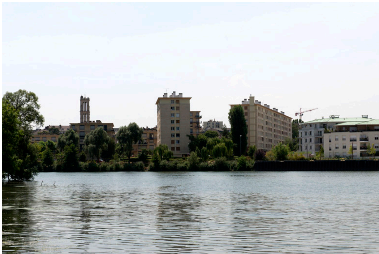
Vue de la résidence du quai de la Tour depuis la Seine.
