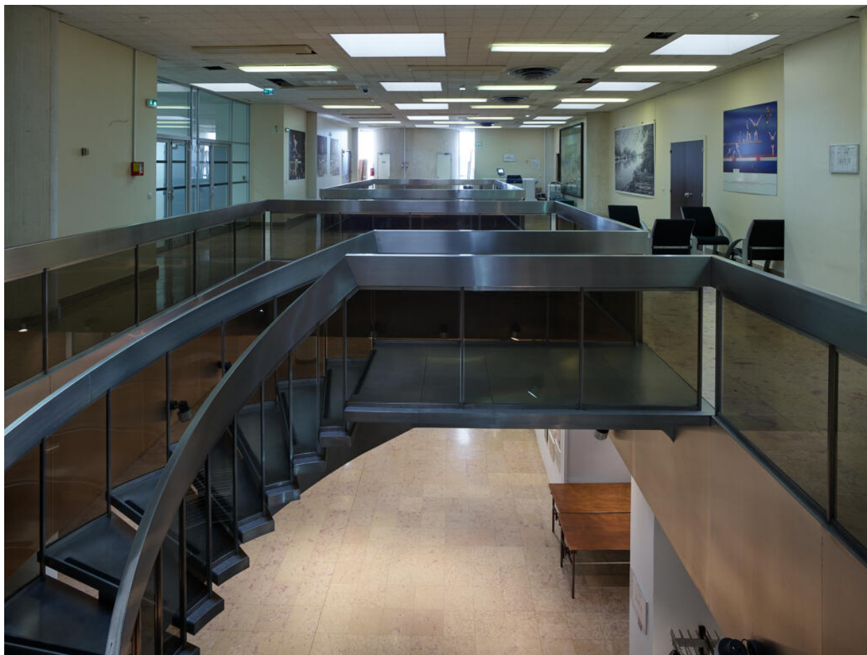
Escalier en vis desservant les bureaux du deuxième étage. Rampe en acier inox et garde-corps en verre fumé.
