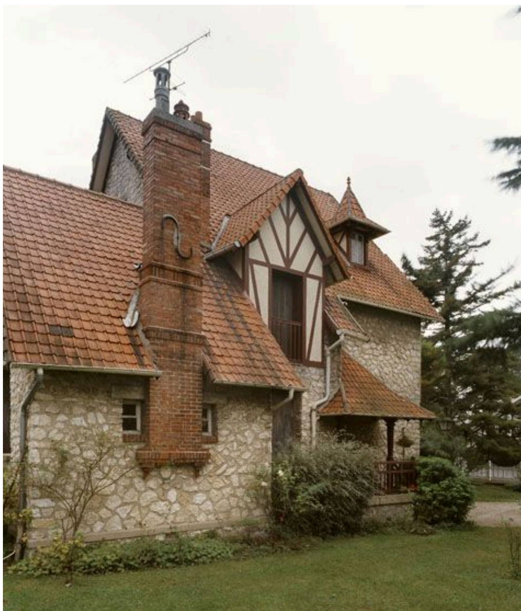
Vue d'ensemble de la façade nord.
