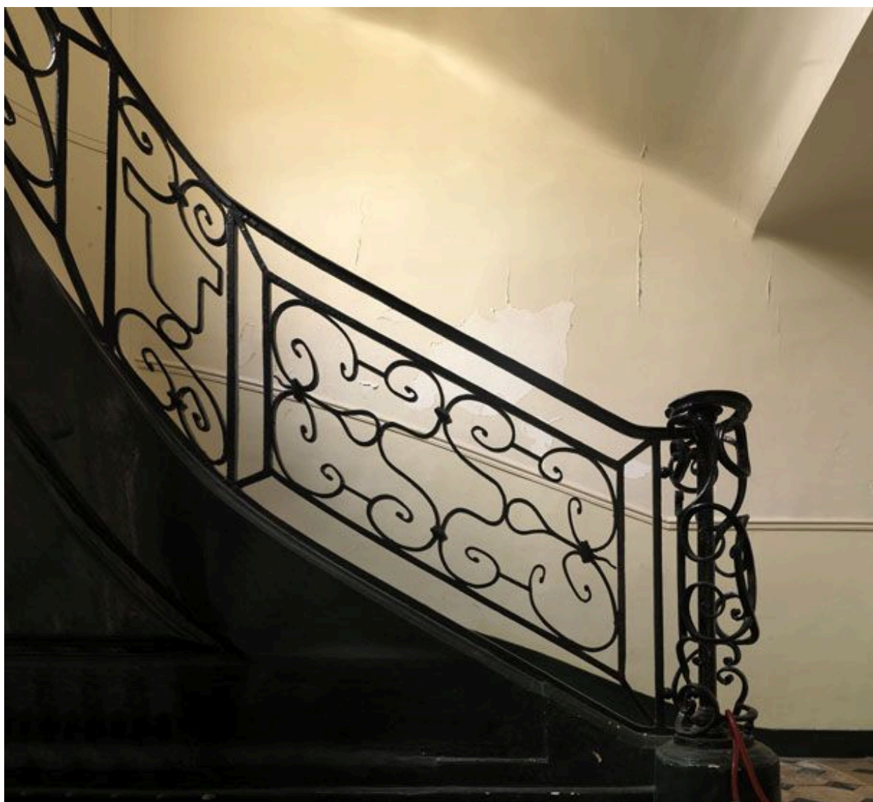
Départ de l'escalier A, 99, rue du Bac.
