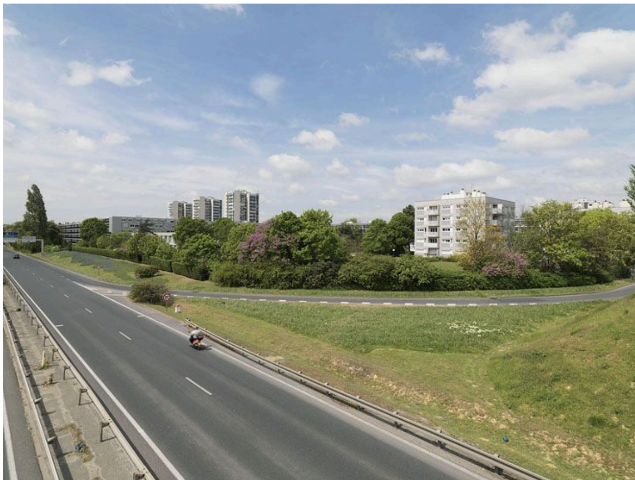
Vue générale du sud du grand ensemble depuis l'avenue du maréchal Koenig (D188).
