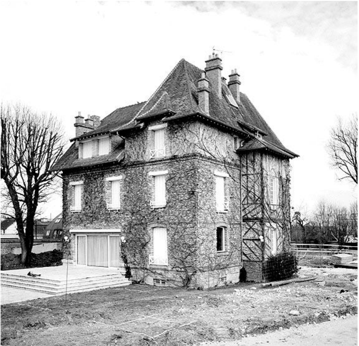
Vue d'ensemble : élévations sud (latérale) et ouest (arrière).
