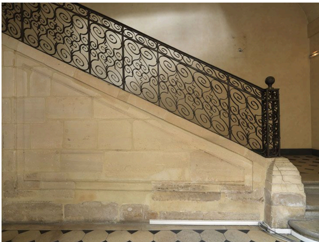
Vue du départ de la rampe.
