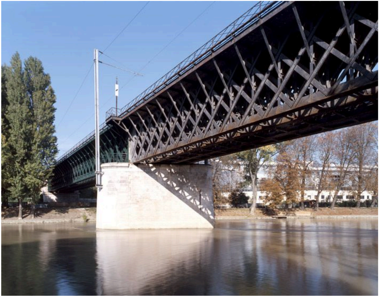
Pont de la Grande Ceinture. Vue depuis la rive de Saint-Maur-des-Fossés du pont métallique enjambant la Marne construit en 1877.
