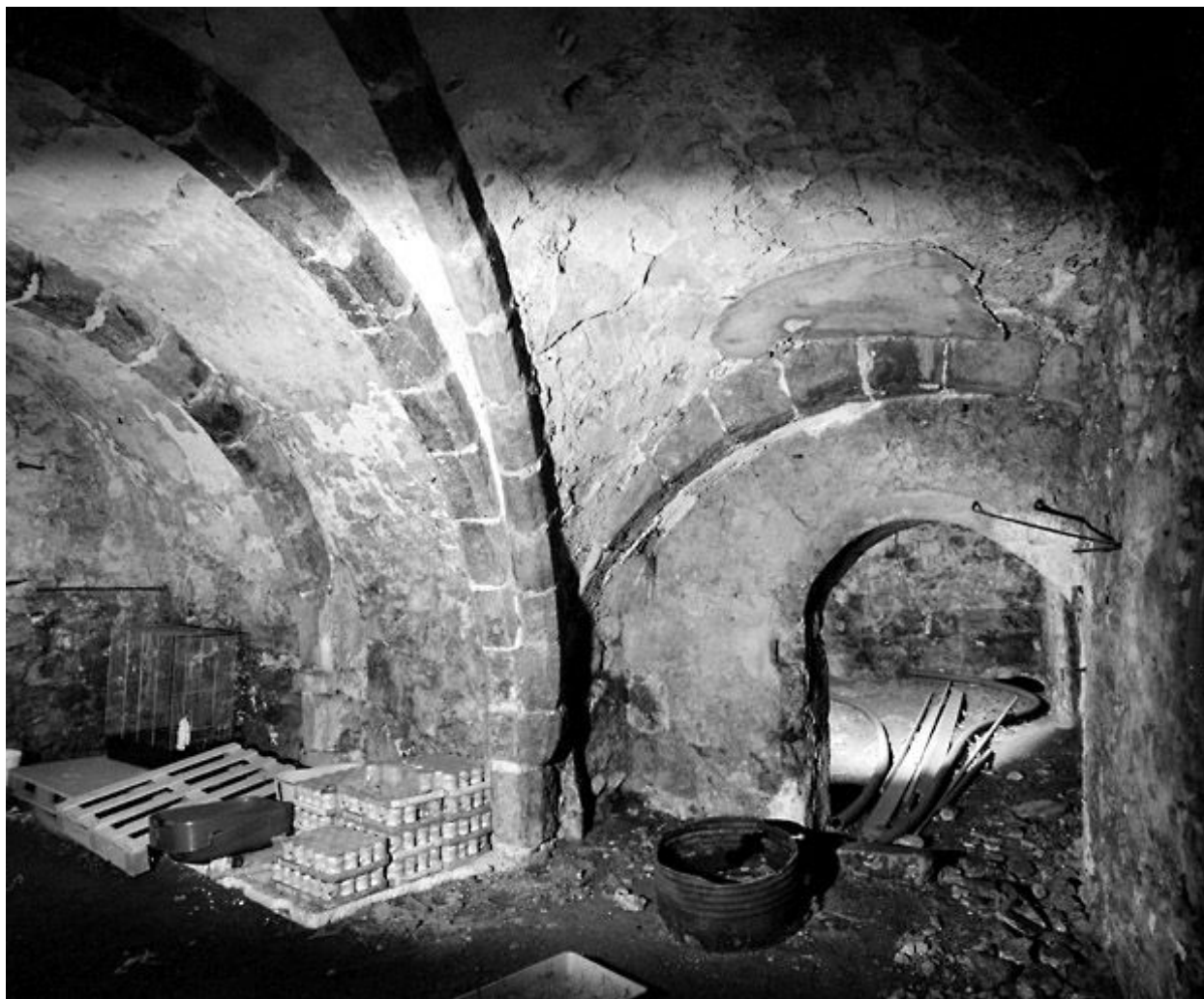
La cave : vue prise depuis l'angle nord-ouest.
