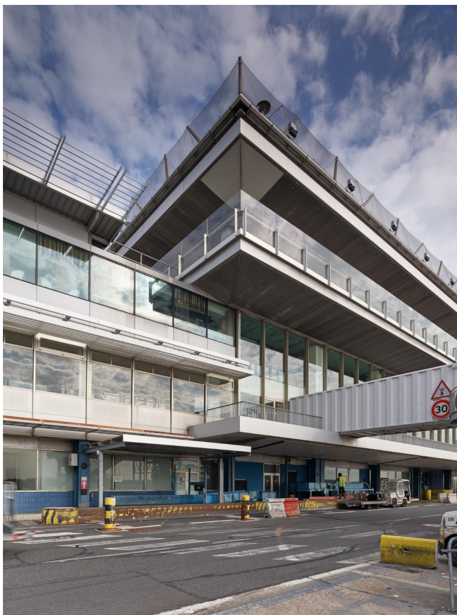
2018, Orly-Sud: le corps central et la jetée ouest vus depuis le sud ouest.
