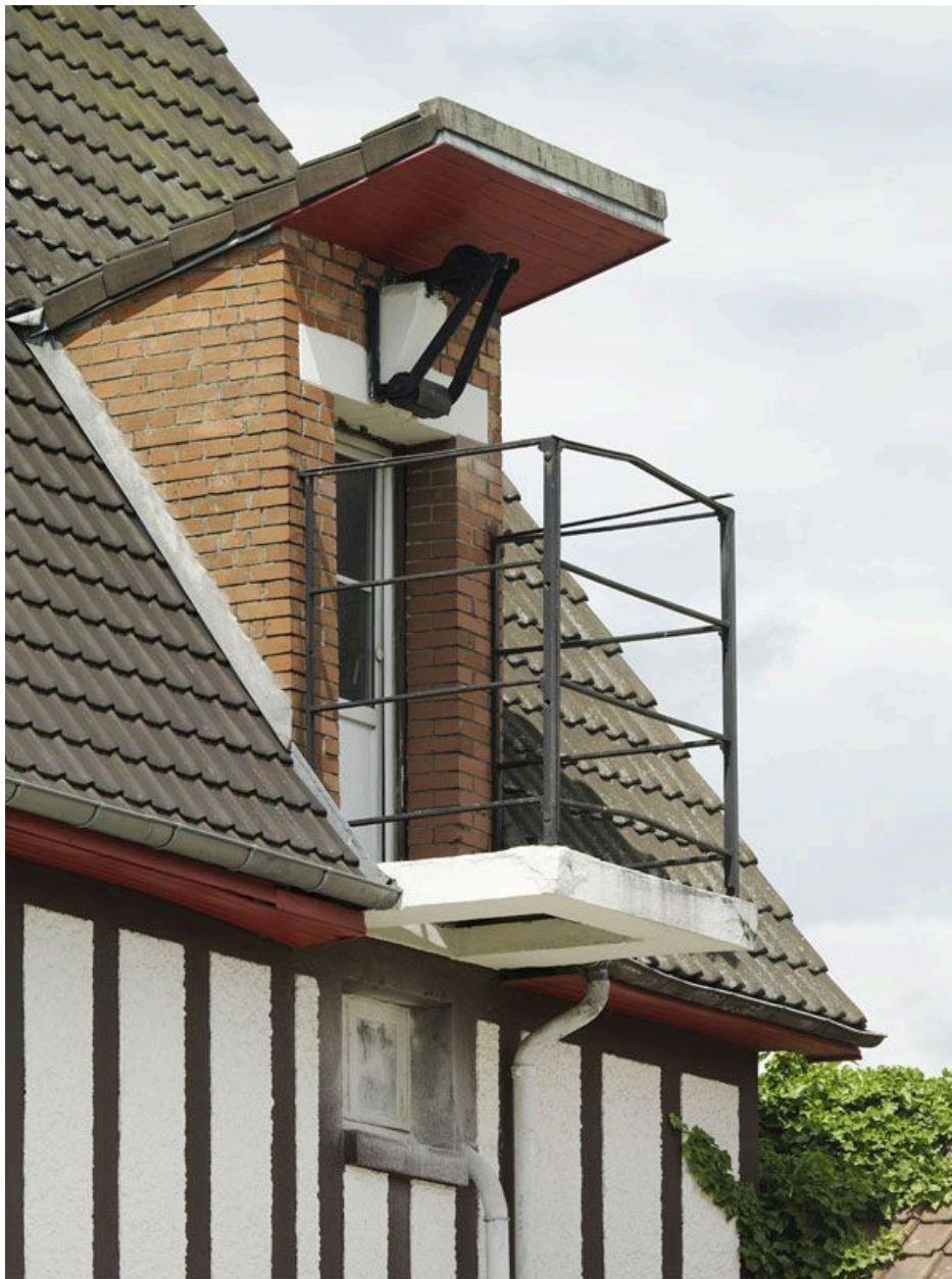
Porte haute avec sa poulie pour monter les sacs de farine.
