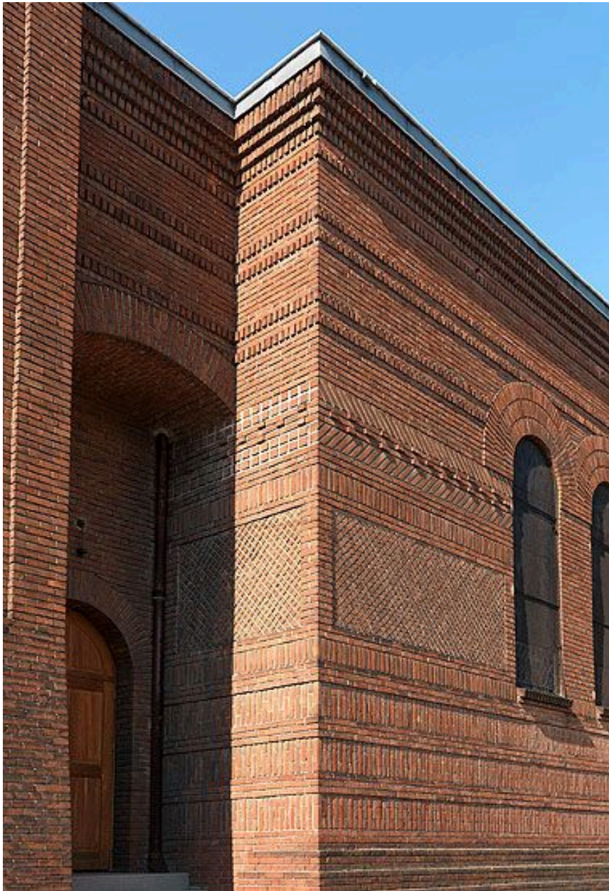
92, Châtillon, église Notre-Dame du Calvaire, 2 avenue de la Paix. Maçonnerie d'un mur latéral.
