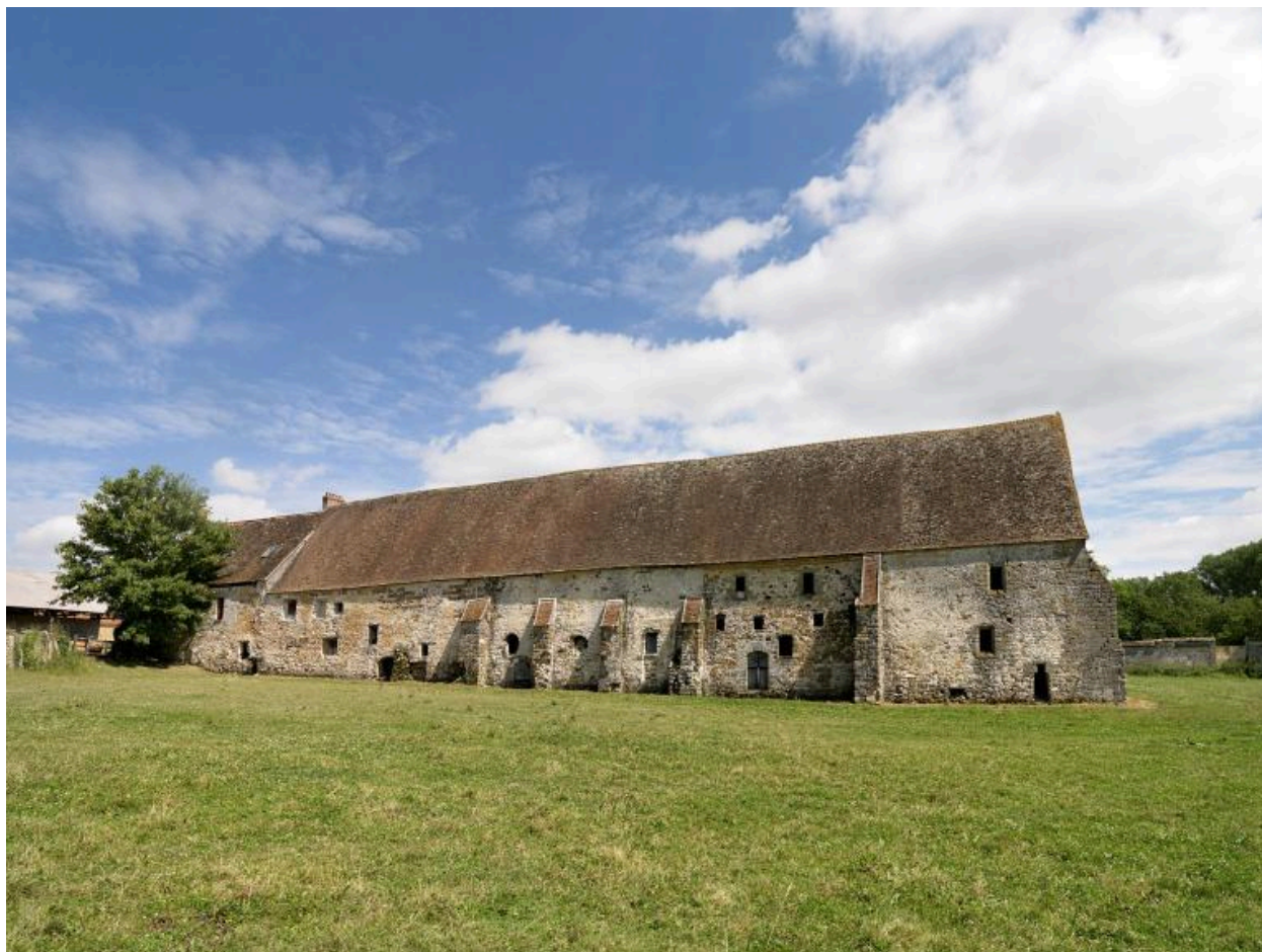
Façade ouest de la grange des Beauvais.
