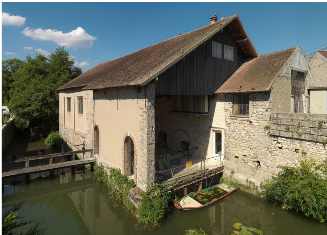
Vue extérieure. Vanne de barrage sur le Loing.
