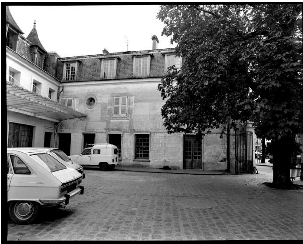
Immeuble, ancien hôtel du Grand cerf, République (place de la) 5. Vue de la façade sur cour.
