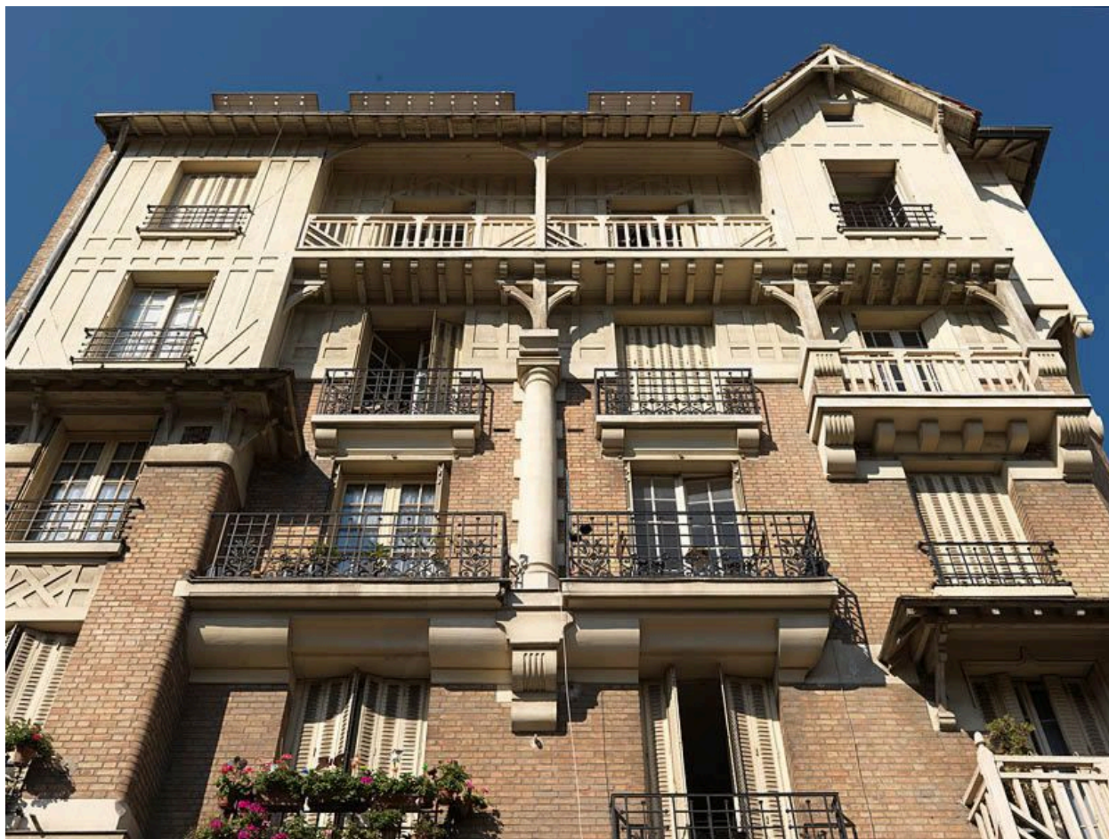
Villeneuve-Saint-Georges, immeuble, 31 rue Henri Janin . Vue rapprochée de la façade.
