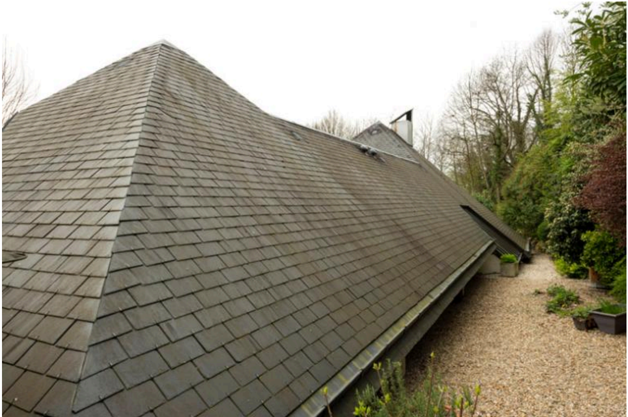
Vue générale de la façade postérieure.
