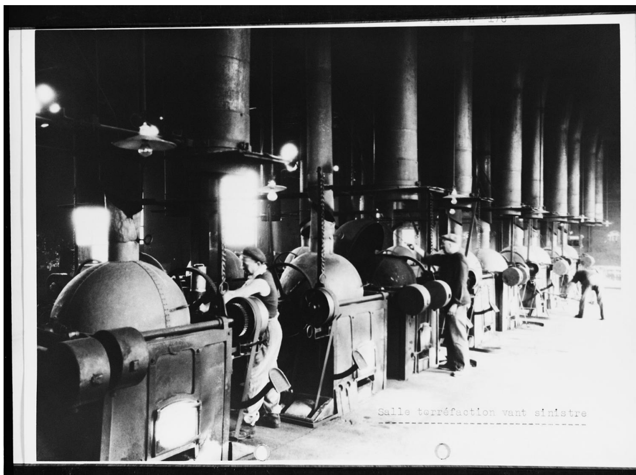
La salle de torréfaction avant le sinistre.
