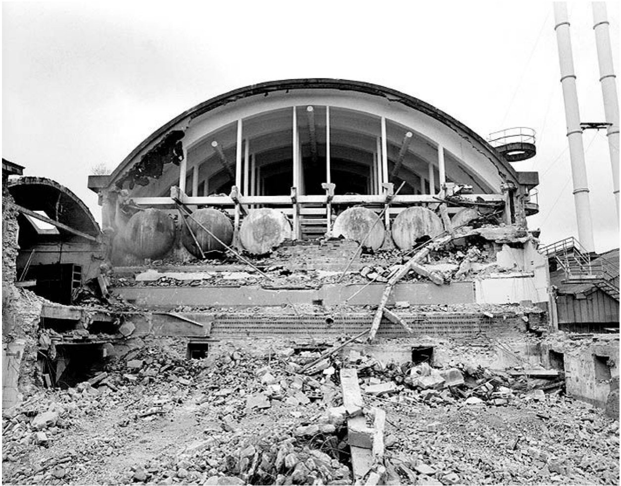
Pignon est du cuvage, en cours de démolition. Photographie avant destruction, 1989. (Ministère de la culture, Inventaire général. 89SG716X)
