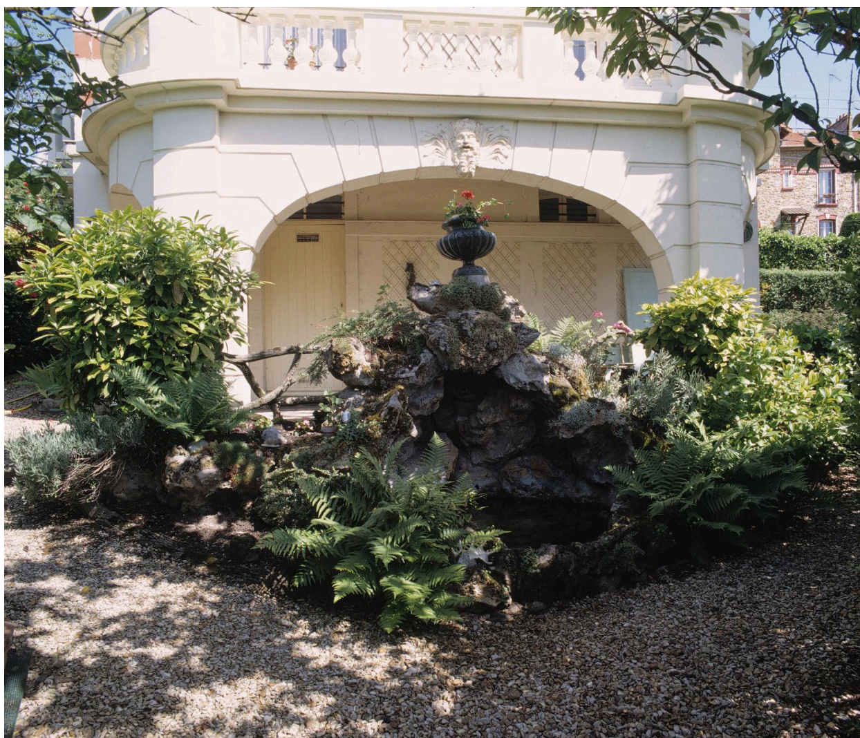
Vue du bassin en rocaille situé au pied de la terrasse.
