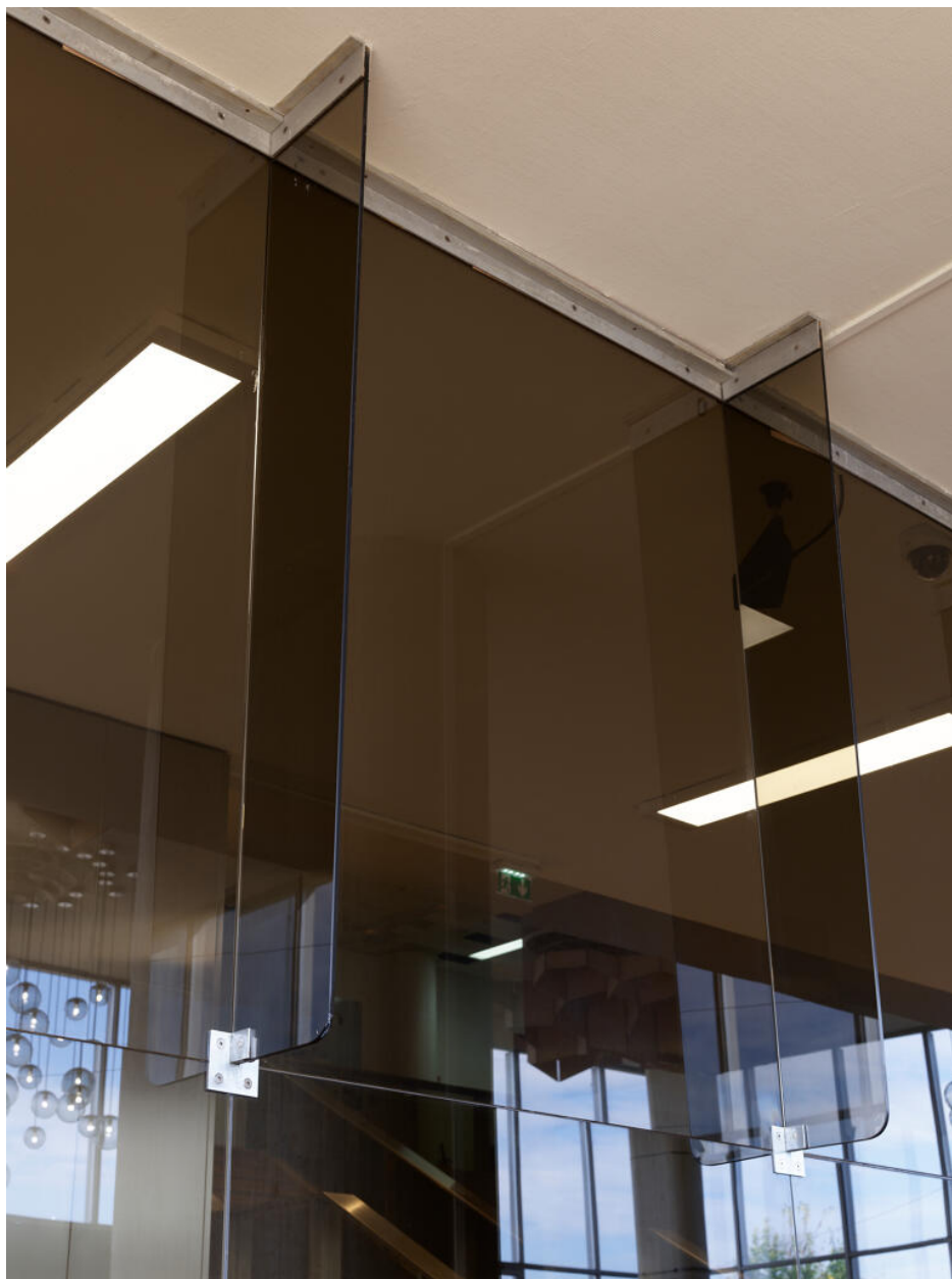
Salle des fêtes. Détail du contreventement du mur d'entrée de la salle, en verre fumé.
