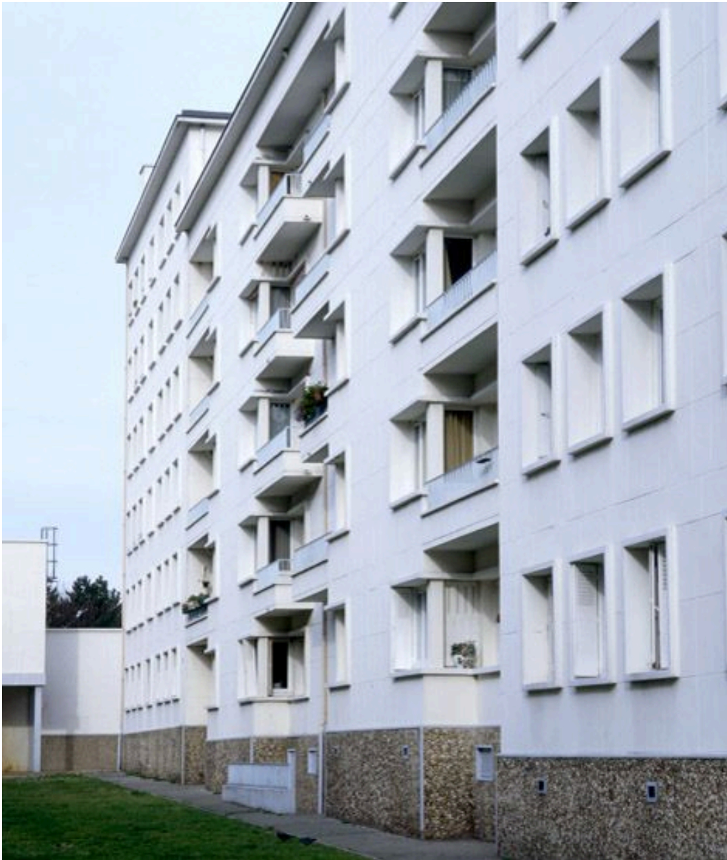
Cité Blanche, avenue de la République, rue Fernand Pelloutier, boulevard Jules Guesde, boulevard Gabriel Péri. Autre détail d'une façade comprenant balcons et fenêtres d'angle dans des redants.
