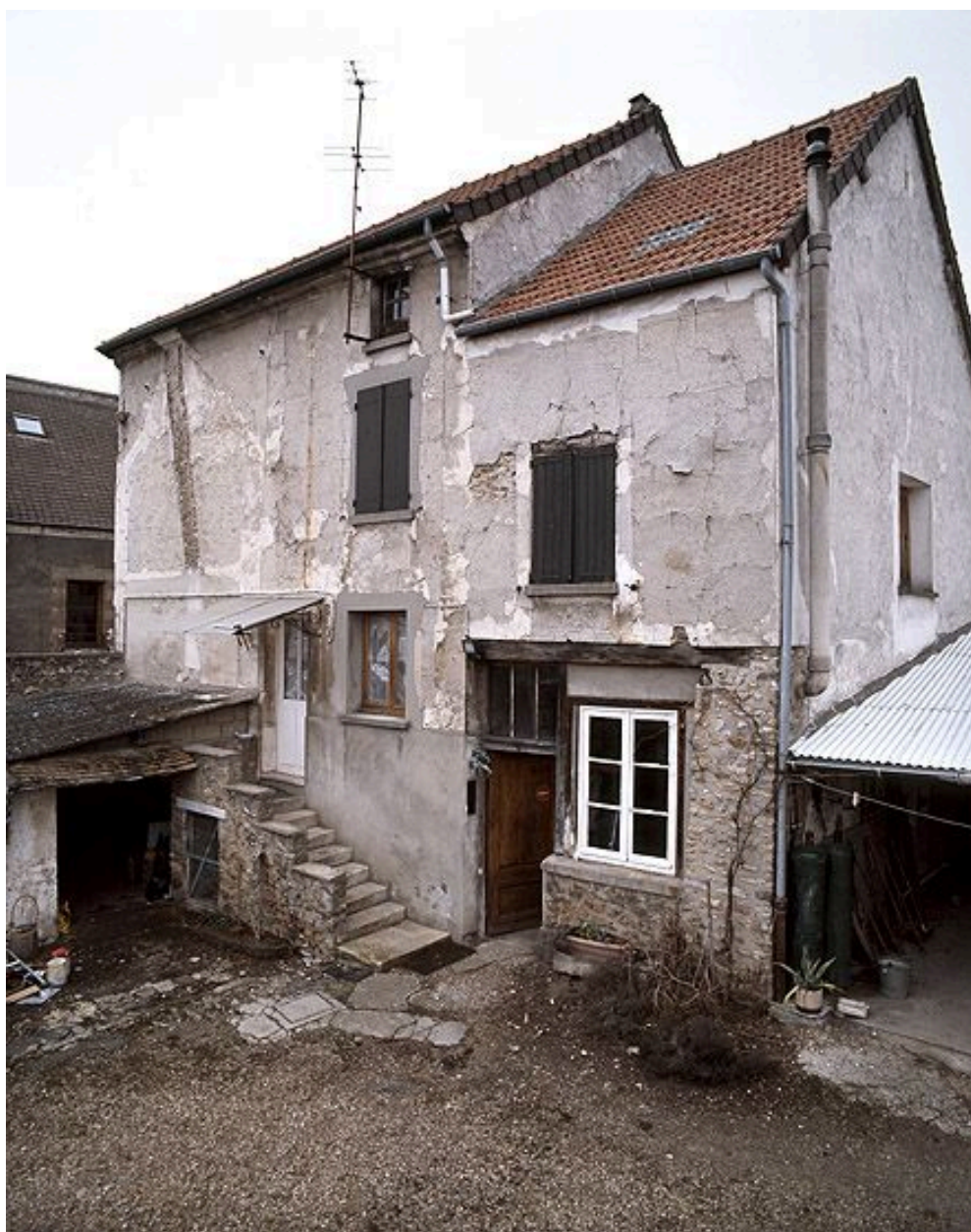
Vue d'ensemble de la façade sur cour.
