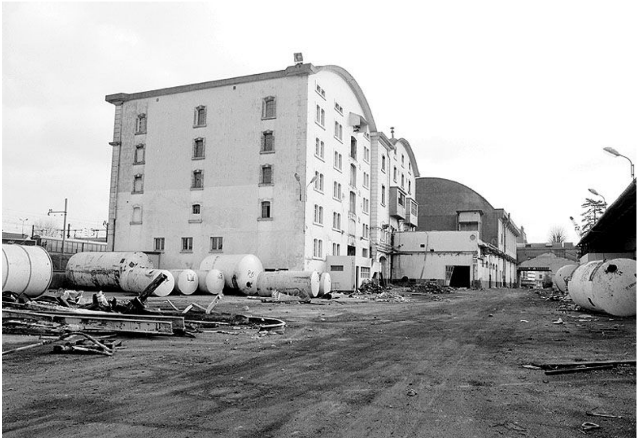
Façade arrière des silos et de la salle à brasser, vue du sud-ouest. Photographie avant destruction, 1989. (Ministère de la culture, Inventaire général. 89SG723X)
