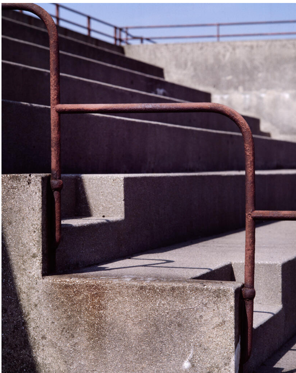
Détail de la tribune. Groupe scolaire dit groupe scolaire Karl-Marx
