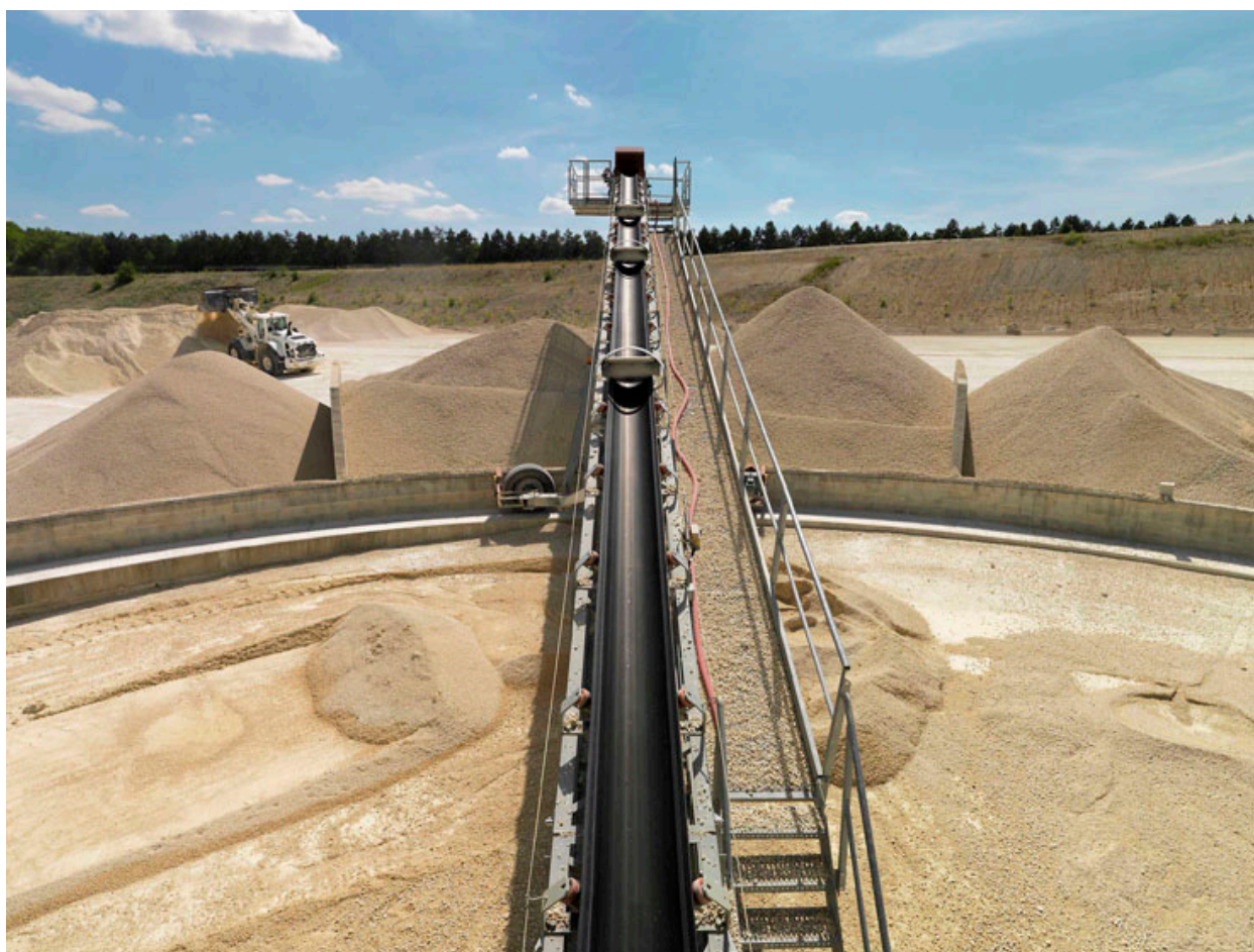
Plateforme - installation secondaire.
