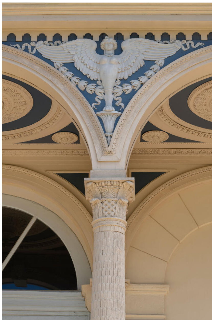
Façade ouest, détail du portique et de son décor de sirènes en bas relief qui se découpent sur fond bleu.
