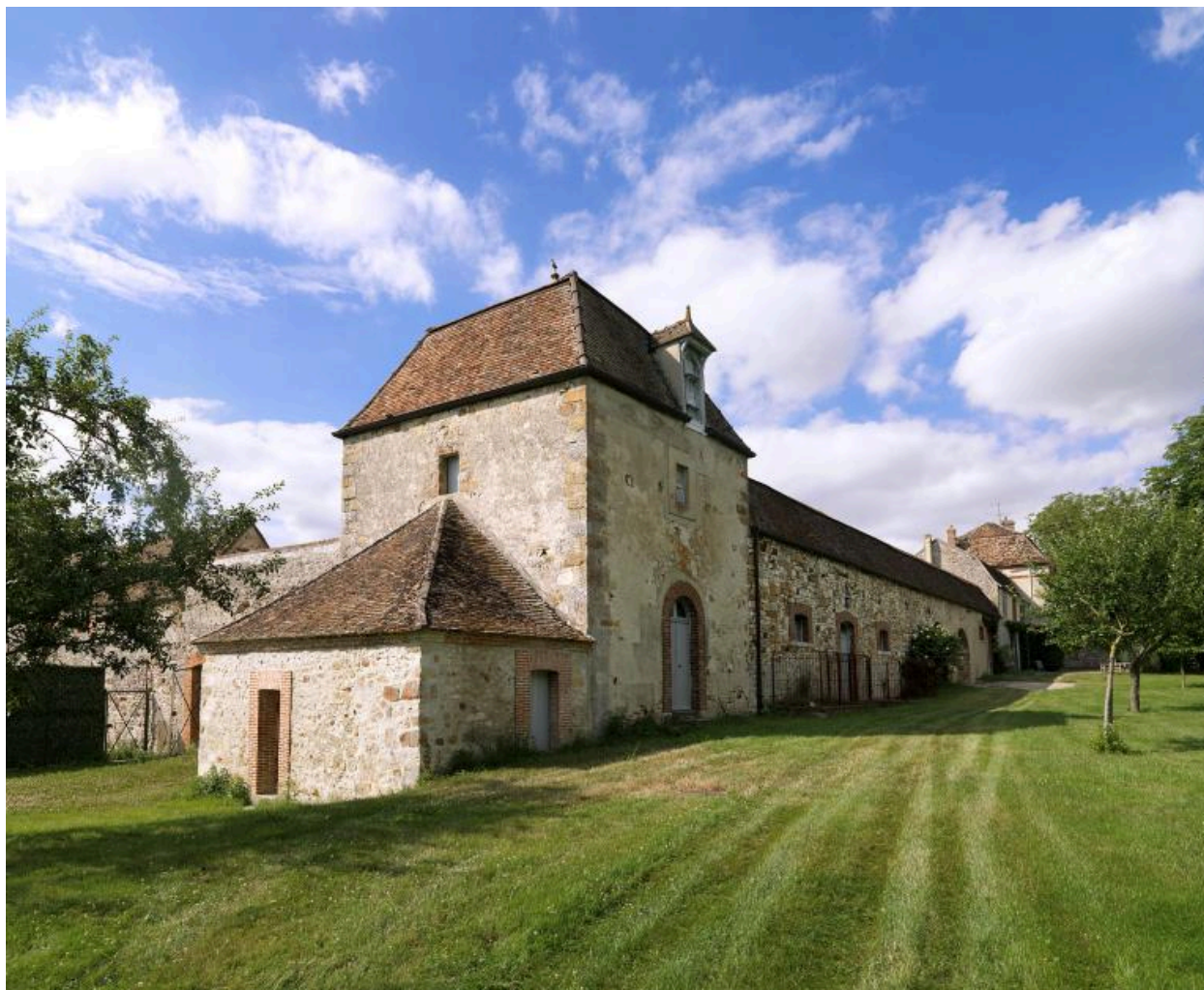
Vue sur la façade est de la grange.
