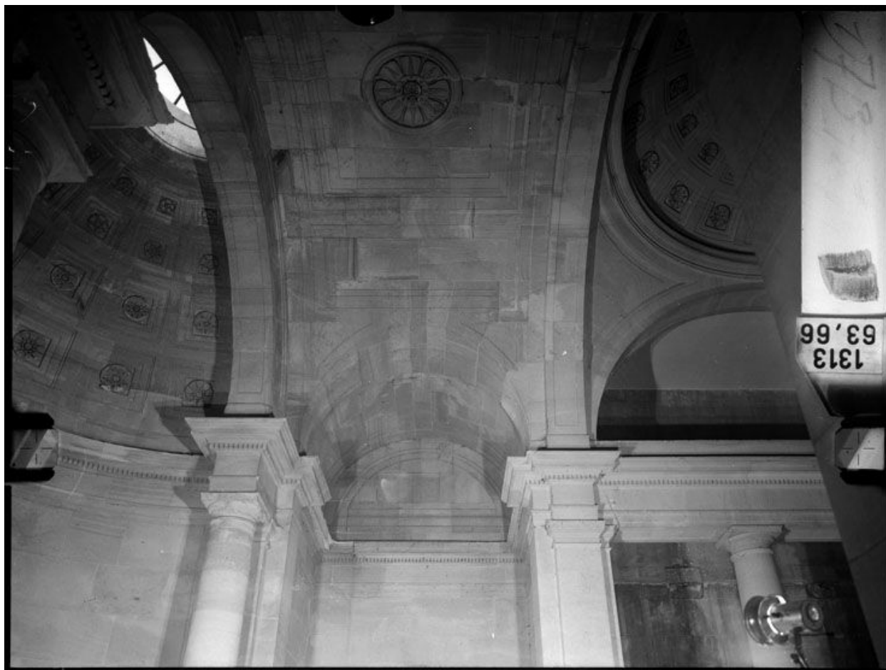
Voûte de la travée droite du choeur.
