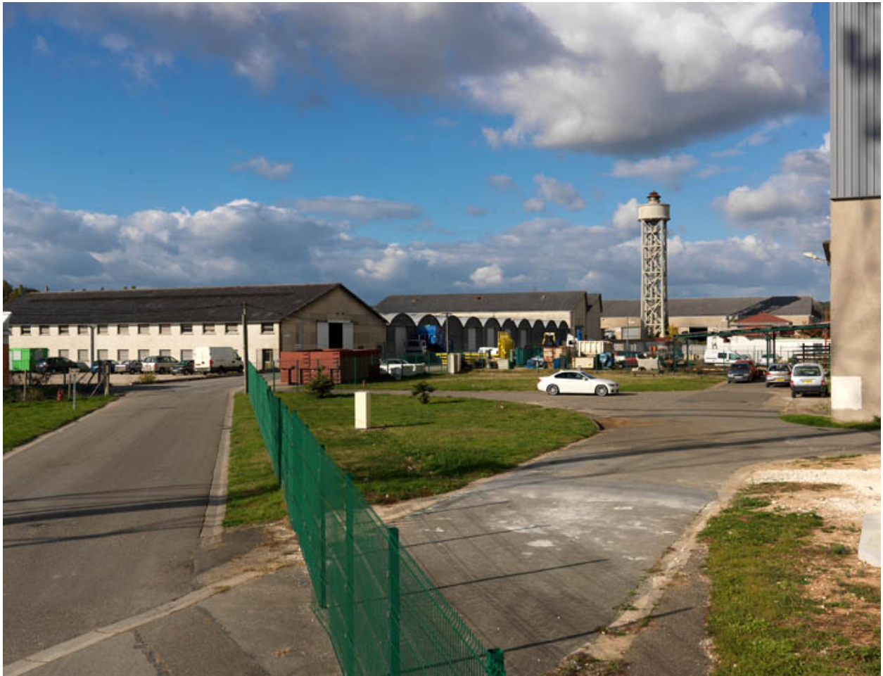
Au fond, le château d'eau (1902) et les dépôts (années 1970).
