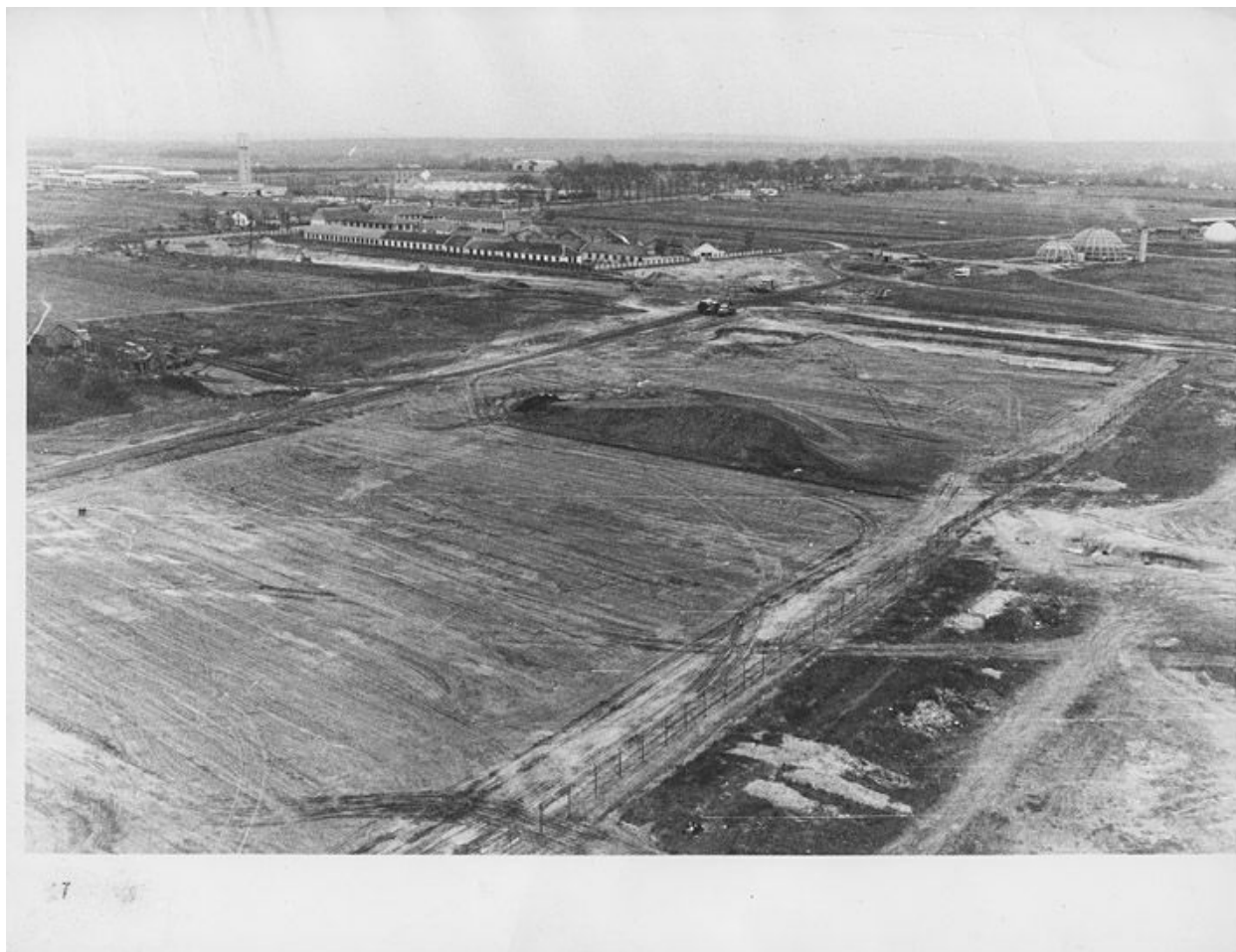
Zone de construction de Beauval A avec vue sur la ZI et à droite la chaufferie. (OPAC Meaux)
