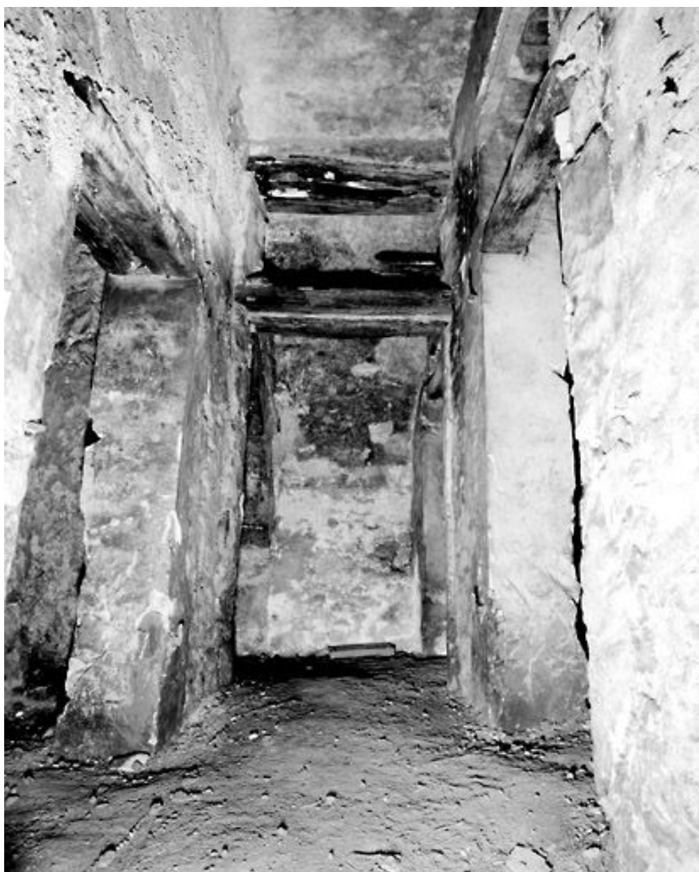
La cave nord : partie ouest (cave médiévale), vue depuis l'allée centrale.
