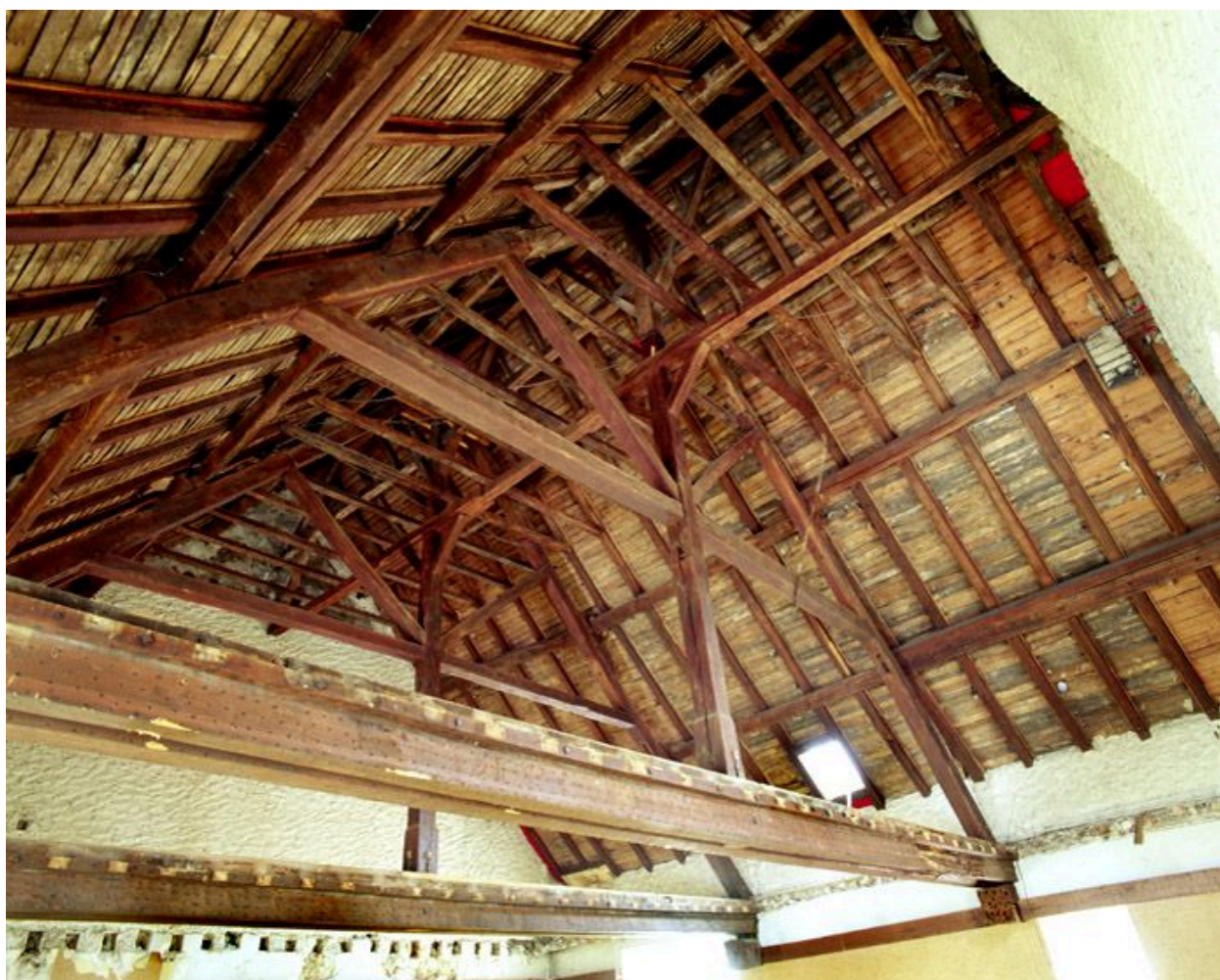
La charpente du premier étage, au-dessus de la salle capitulaire.
