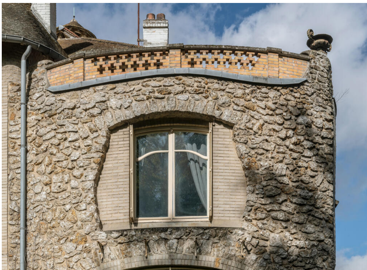
Détail d'une fenêtre et de la balustrade de brique de la façade est.
