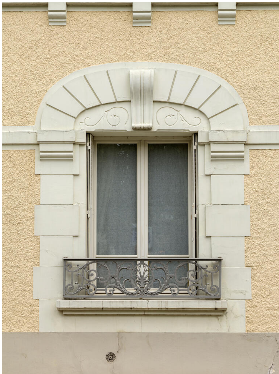
Détail de la façade sur rue.
