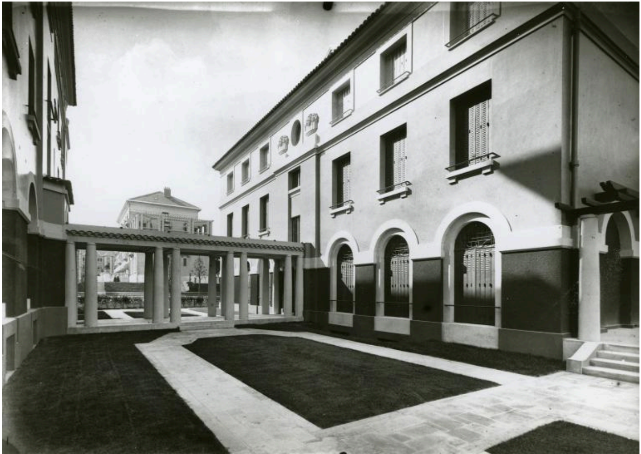
Vue de la galerie couverte, encadrée par un jardin, qui relie les deux pavillons, s. d. (vers 1940). CIUP, centre de valorisation du patrimoine, 33L 00153.
