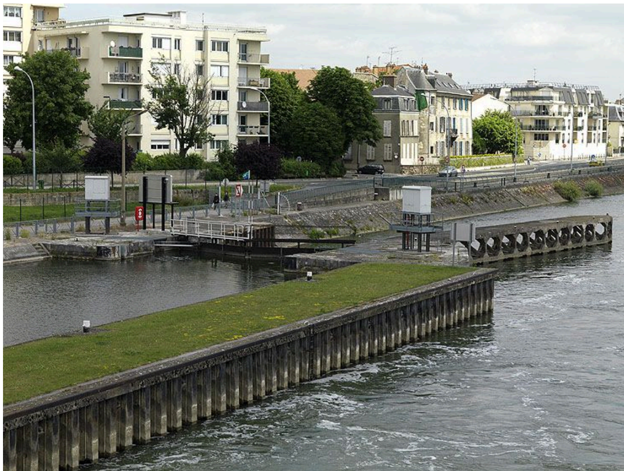
Ablon-sur-Seine, Vigneux. Barrage éclusé. La sortie de l'écluse.
