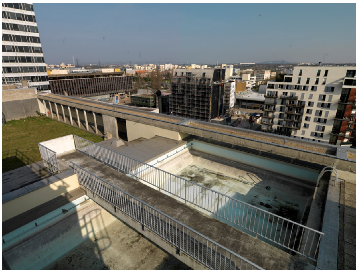
La piscine, sur le toit de la préfecture.
