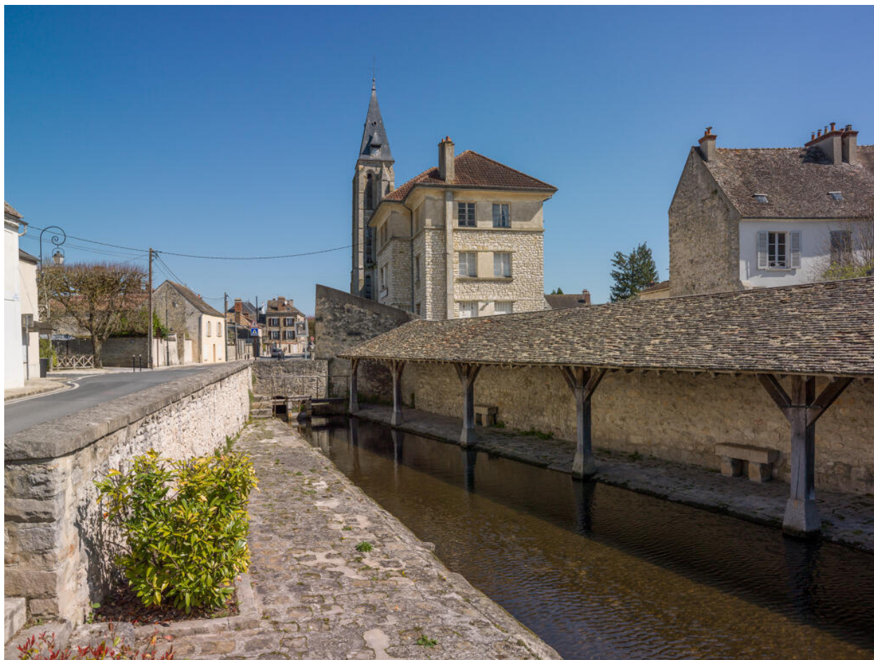
Le lavoir de la Bonde, vue depuis le nord-ouest.
