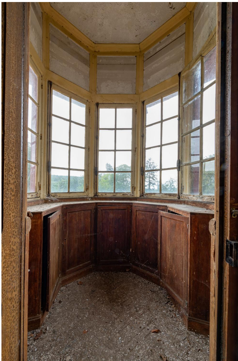
Vue intérieure de l'échauguette
